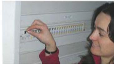
Alle Fehlerstromschutzschalter sind mit einer Prüftaste ausgestattet, die einen Funktionstest erlaubt. Wird die Prüfung nicht durchgeführt, können die Kontakte verkleben. Ein Auslösen im Fehlerfall ist dann nicht möglich.
