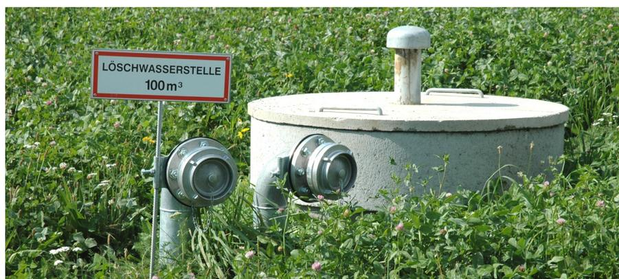
In den vergangenen Monaten konnten nach dem Bau von Löschwasserbehältern in Ebened und Henndorf vier weitere Behälter fertiggestellt werden. Die Standorte beim Winterschlager, beim Hagenhofner, beim Reiebner und in Ottenschlag waren von der Freiwilligen Feuerwehr St. Georgen am
